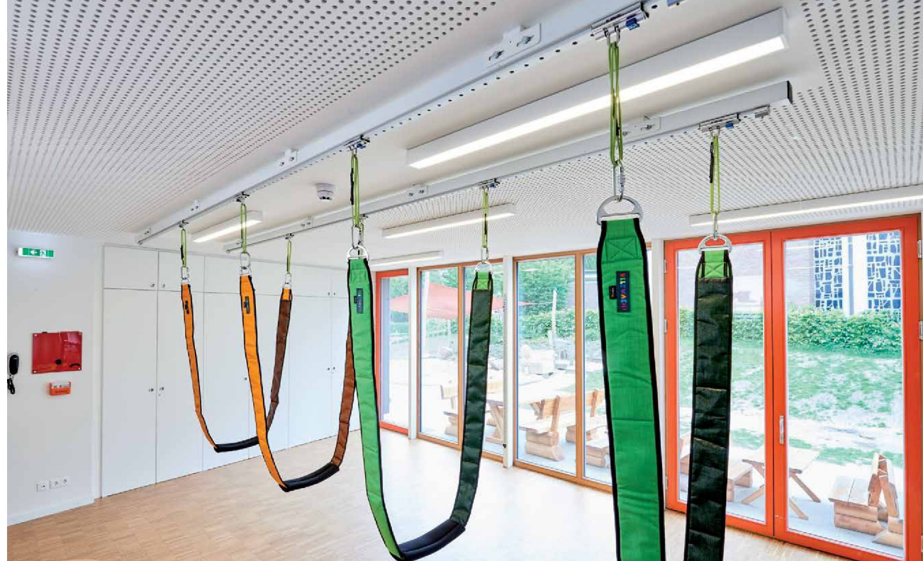
Trägerprofil mit Kassettendecke
